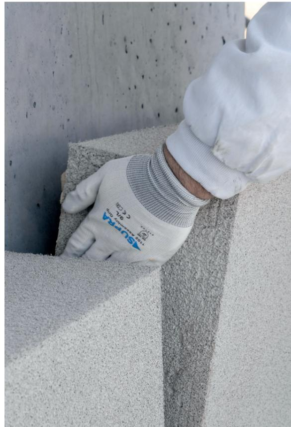
Verarbeitung der Fassadendämmung mit swissporECORIT.
