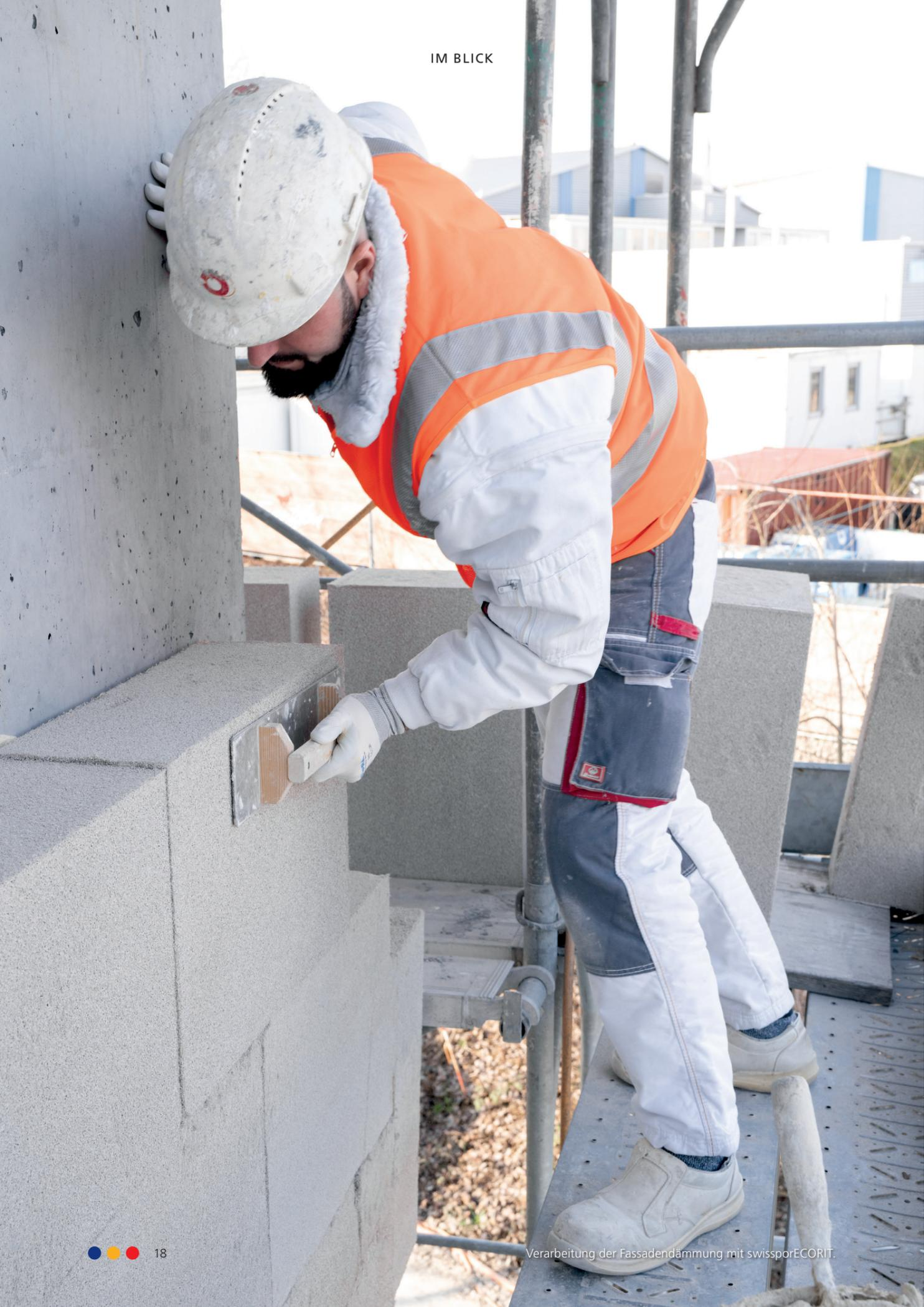
Verarbeitung der Fassadendämmung mit swissporECORIT.
